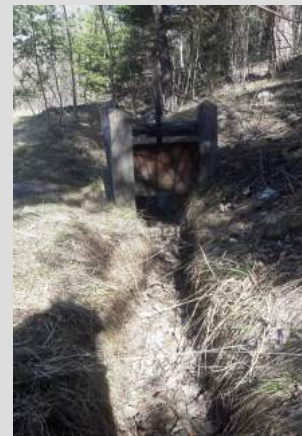
Canal avant sa mise en eau
