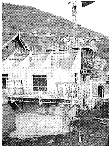
Extension du Bâtiment A
