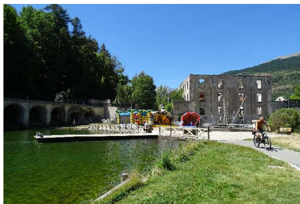
Rénover le quartier de la gare et créer un pôle d'échanges multimodal
