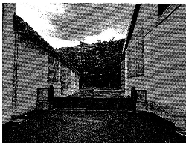
Réalisation des VRD été 2020
