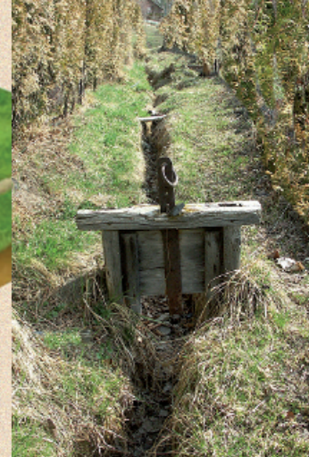
Vanne du grand canal de ville à Fortville
