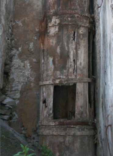
Conduite forcée en bois cerclé, usine de la Schappe
