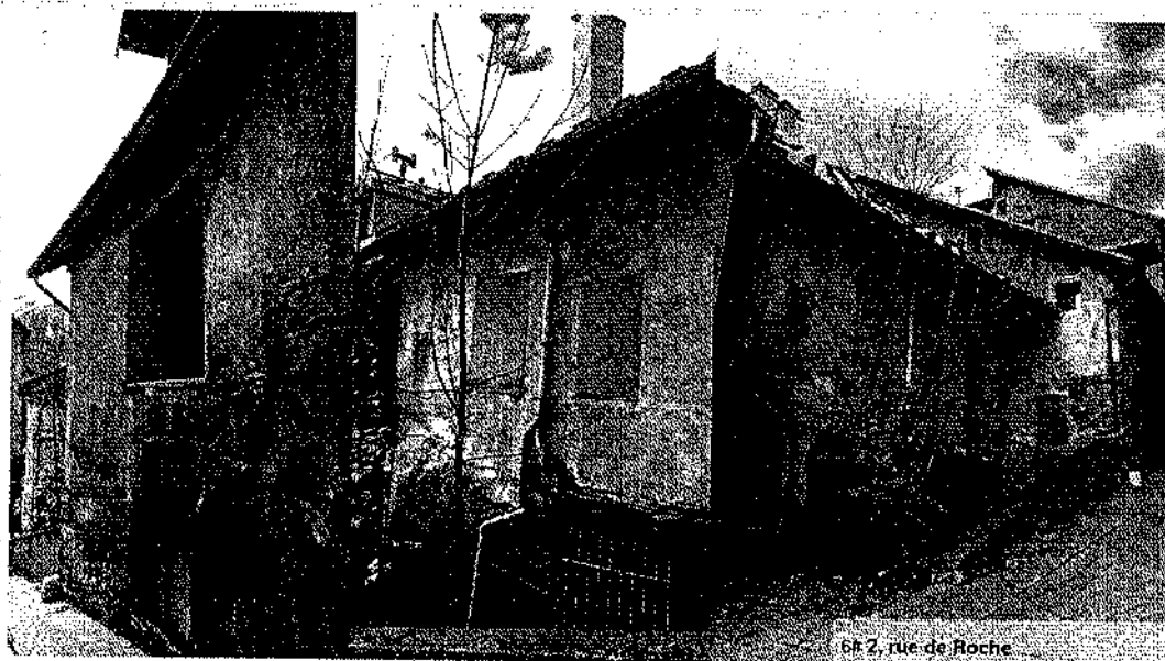
Figure 8 – Exemple de patrimoine bâti – Cité Vauban Villes Vivantes
